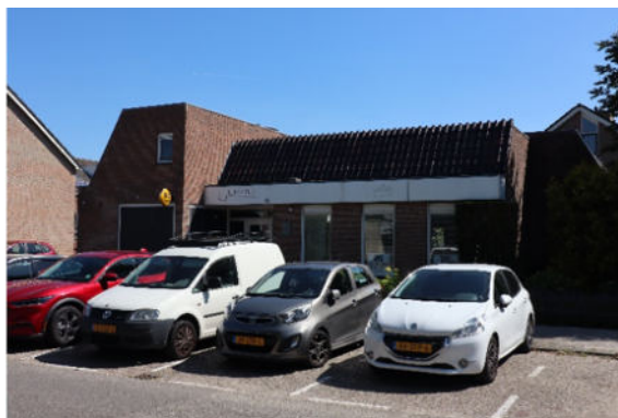
Bestaande parkeerplaatsen voor bankgebouw.
