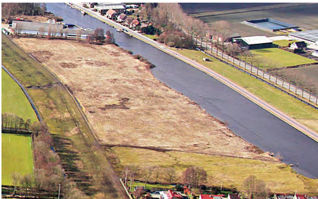
Figuur 2.4 Beeld waarin de oorspronkelijke oeeververdediging zichtbaar is (1)
