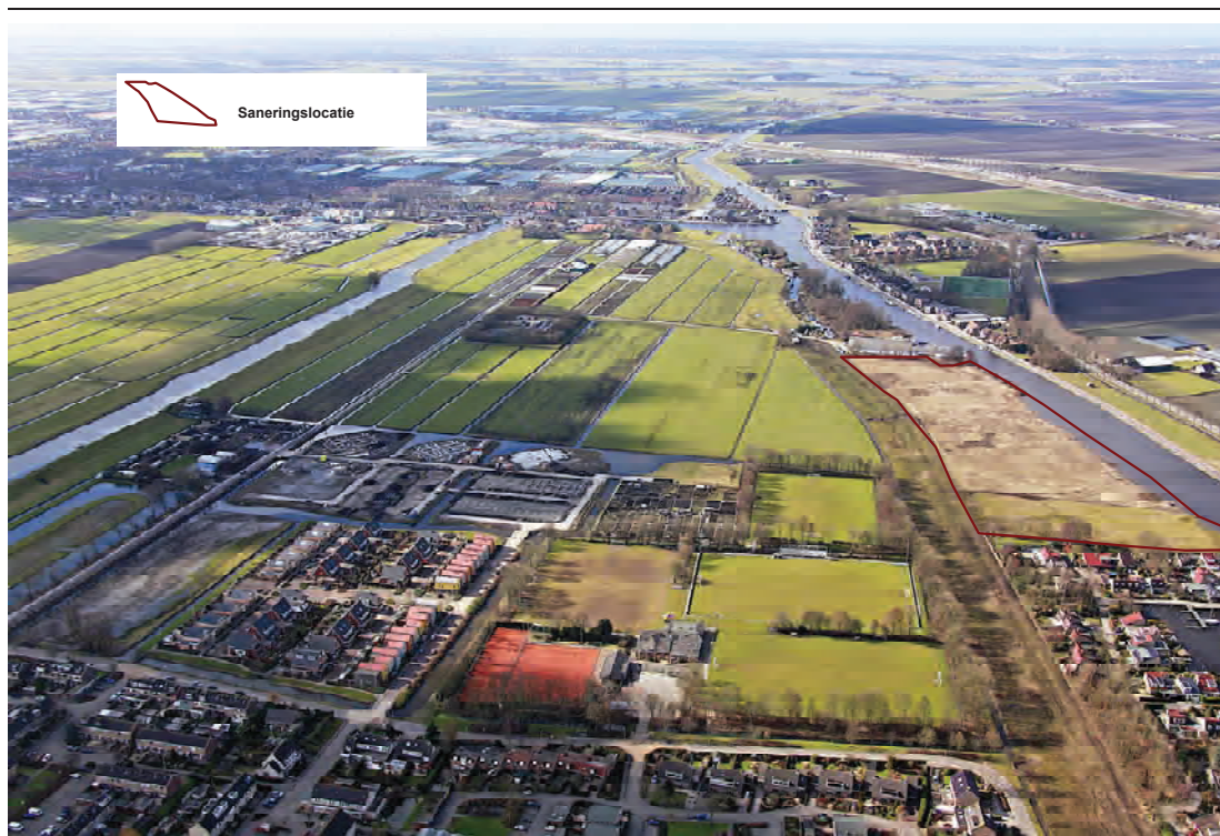
Figuur 2.2 Luchtfoto-overzicht van de braakliggende locatie. Hierop is duidelijk waar te nemen dat er sprake is van afkalving van de oever
