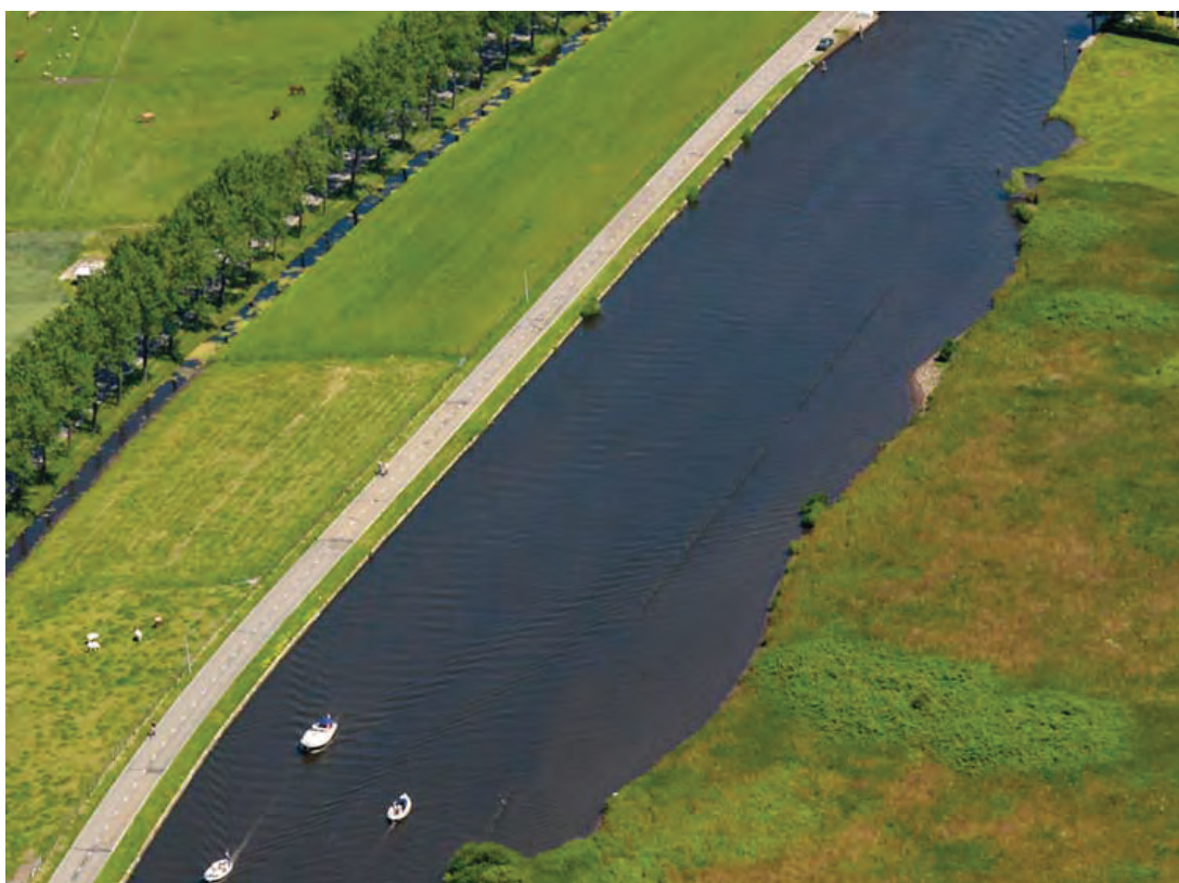
Figuur 2.5 Beeld waarin de oorspronkelijke oeeververdediging zichtbaar is (2)
