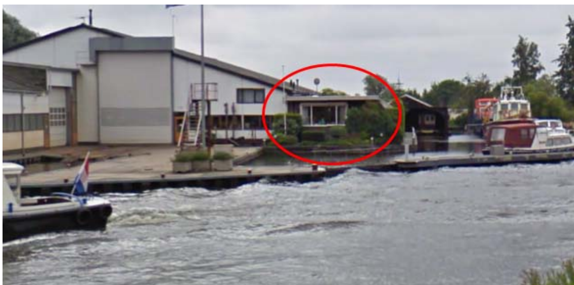
Figuur 1.1 - Zicht op de huidige bedrijfswoning
