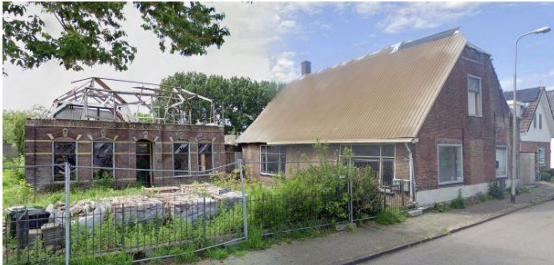
Oude bebouwing vlak voor de sloop (bron: Van Wilsom Van Loon architectuur & stedenbouw)
