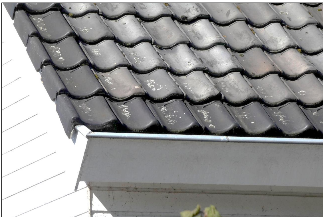
Figuur 10: De woning aan de voorzijde van het perceel heeft een vogelwerende dakrand, waardoor huismus geen toegang heeft tot onder de dakpannen.
