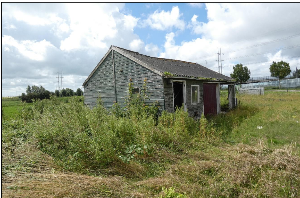
Figuur 3 De schuur is opgebouwd uit hout met een golfplaten dak.
