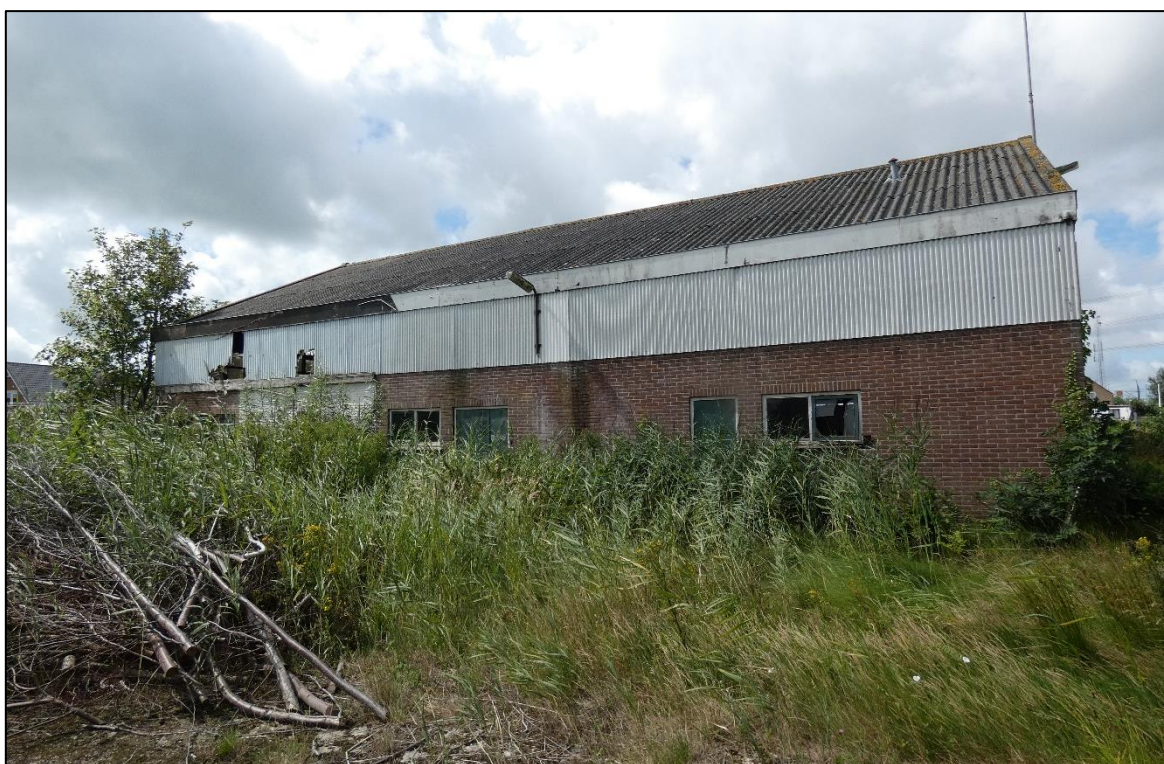
Figuur 2 De bedrijfsgebouwen bestaan uit bakstenen en golfplaten met een golfplaten dak.
