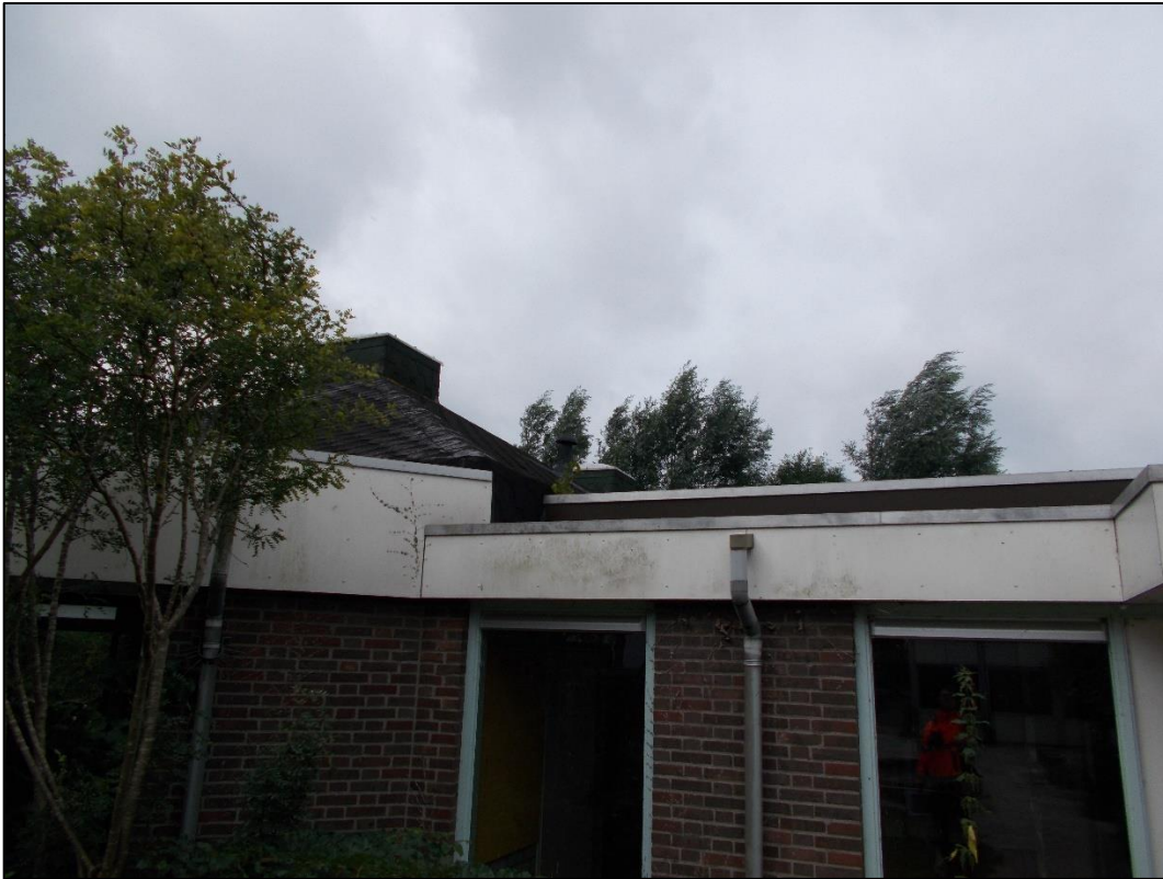
Foto's 12 t/m 17: mogelijke verblijfplaatsen van vleermuizen
