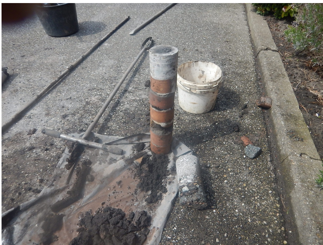
Figuur 39: Baksteenlaag onder het asfalt in boorprofiel 1.
