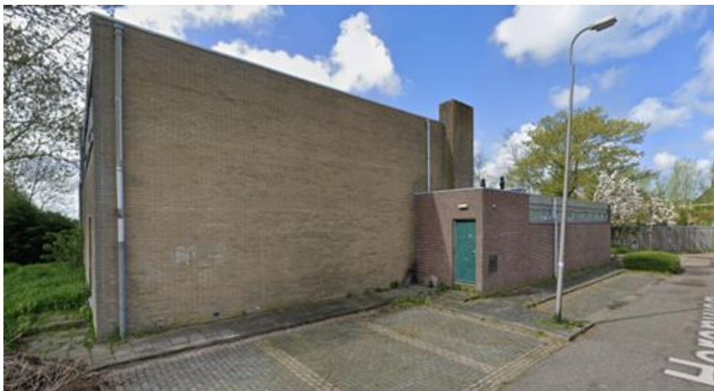
Afbeelding 7: Huidige situatie van het te slopen gebouw (sporthal) (bron: Google maps)
