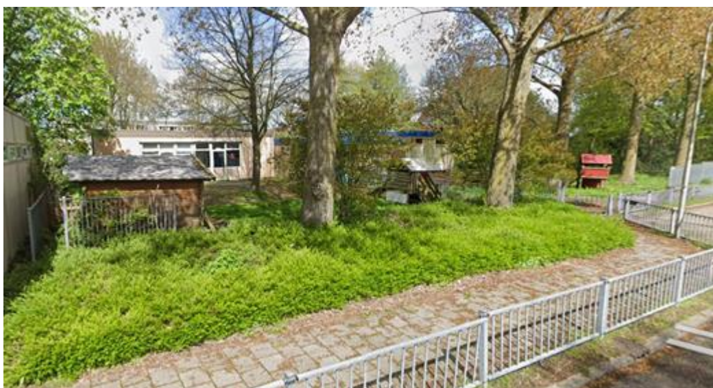
Afbeelding 5: Huidige situatie van het te slopen gebouw (kinderdagverblijf) (bron: Google maps)
