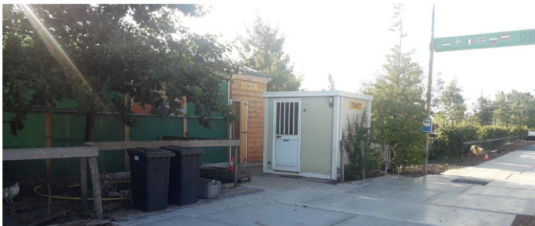
Toiletgebouw ten behoeve van verblijfsrecreatie
