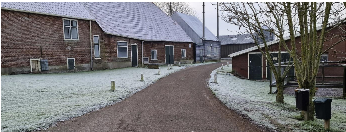
illustratie 5-3 Weg tussen boerderij en stallen. Verloop van de dijk volgens de Legger. (beeld: ir. wim klaassen – ARCHITECT)
