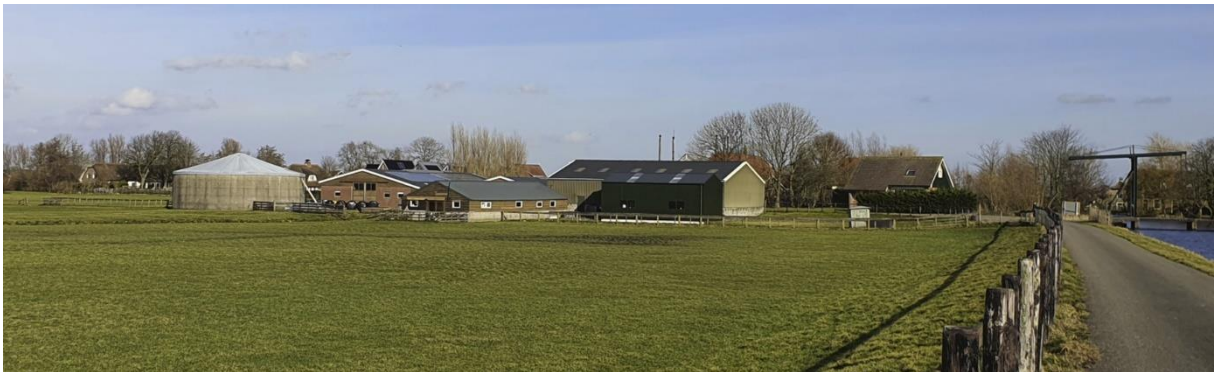
illustratie 3-3 Zicht op het bebouwingscluster Zwarteweg 8 vanuit het westen. (beeld: ir. wim klaassen - ARCHITECT)
