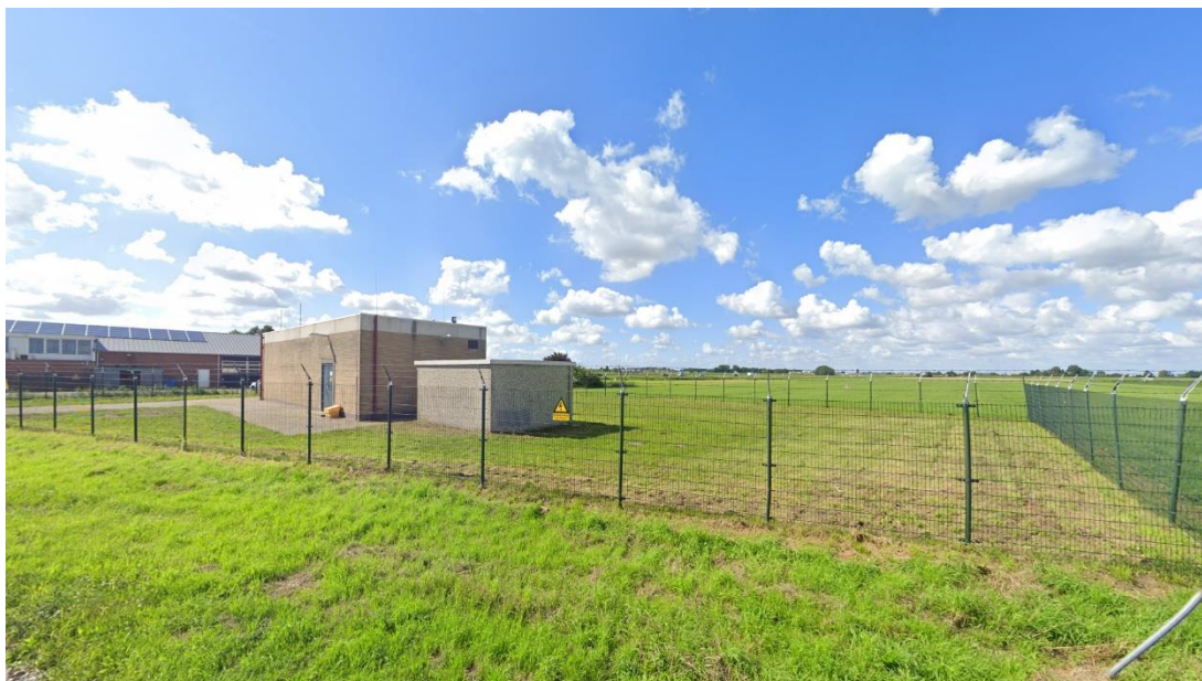
afbeelding 4: aanzicht van het bestaande onderstation met er achter het terrein van de beoogde nieuwbouw (bron: Google Streetview)
