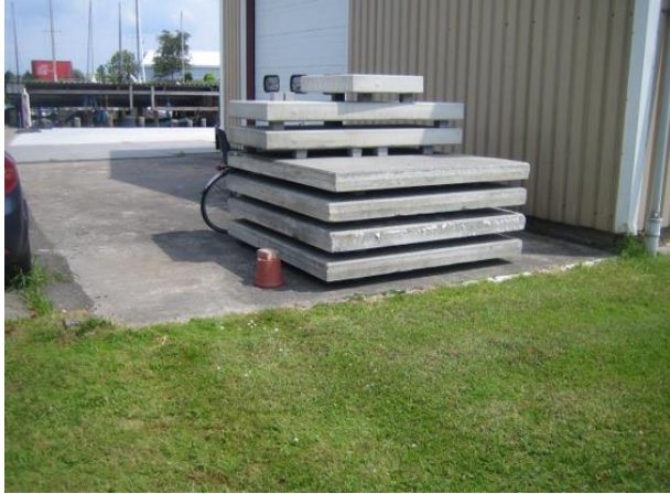
Afbeelding 23, bestaande fundering waarop de extra bebouwing is voorzien
