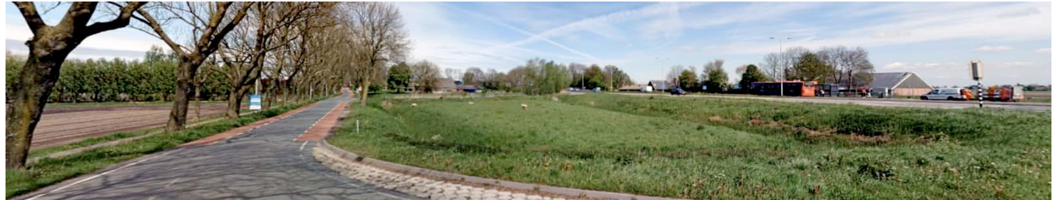
1,2,3) De zuidkant toont zich gedurende langere tijd in de benadering; de bebouwing in het plangebied toont ..
