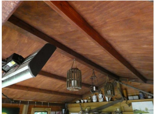
Figuur 17: Binnenkant van de overkapping
