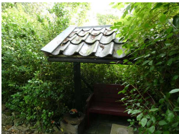
Figuur 8: Overkapping aan de oostkant
