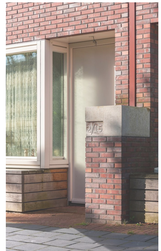
HWA in het metselwerk
